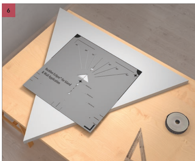
Plasser markeringsmalen slik at senterlinjene tegnet i trinn 5 flukter den store trekanten og diamantutskjæringen. Se detaljer på bilde 6.
