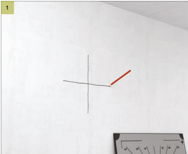
Lag et kryss på veggen som indikerer midten av Rockfon Eclipse veggabsorbenten. Den øverste delen av krysset skal være +/- 30 cm.
