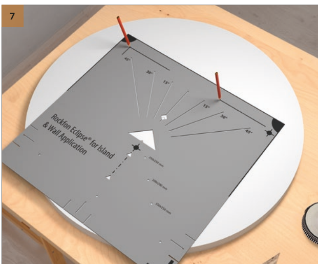
7 Marker linjene hvor opphengsbeslaget skal monteres. Se detaljer på bilde 7.
