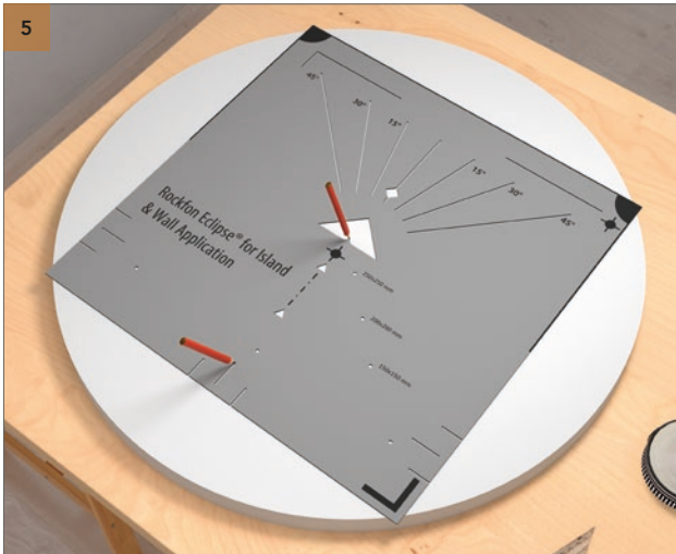
5 Plasser merkeplaten på baksiden av veggabsorbenten og marker den lille spissen i trekantutskjæringen og marker plasseringen av avstandsholderen. Se detaljer på bilde 5.
