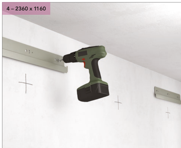
Bor hullene og installer veggbeslagene.
