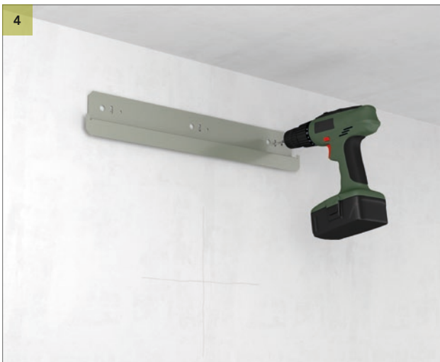
Bor hullene og installer veggbeslaget.
