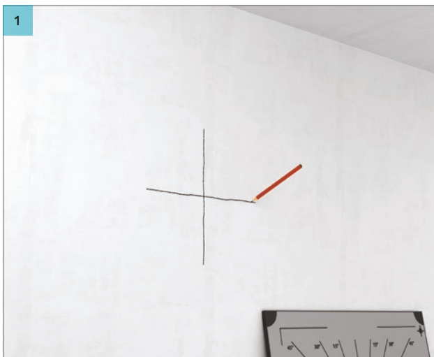
1 Lag et kryss på veggen som indikerer midten av Rockfon Eclipse veggabsorbenten. Den øverste delen av krysset skal være +/- 30 cm.
