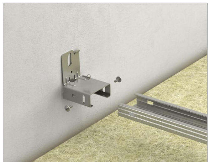
Motholdsprofil montert på vegg.
