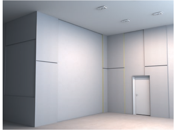
2.3 Alle ytre plater montert med horisontale profiler.
